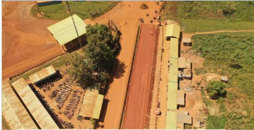
Section d'essai routier en béton
