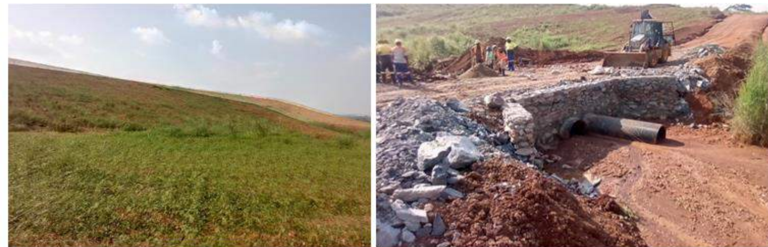
Pict 12. Rehabilitation et drainage des eaux autour des TSFs
