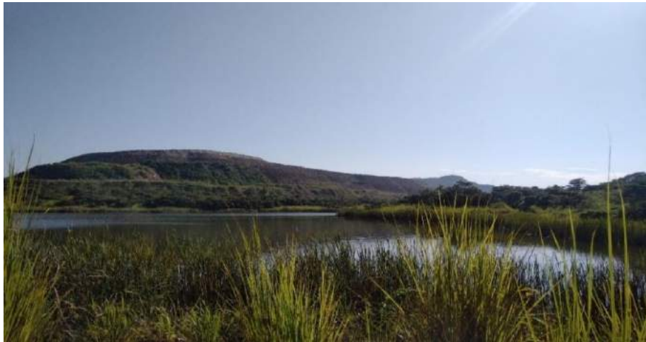
Pict 5. Digue finale de décantation – en amont de toutes nos opérations
