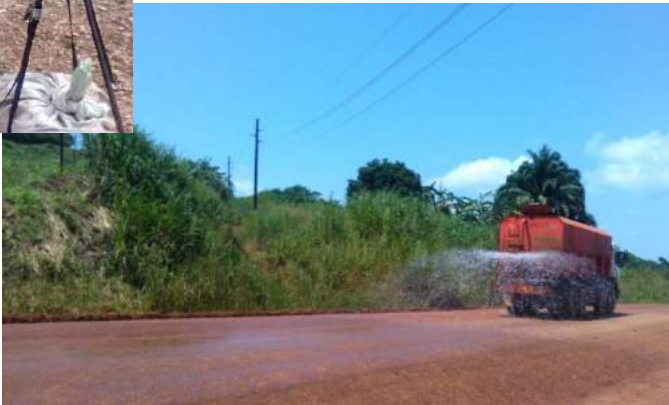
Pict 2. Pratiques de suppression de la poussière Avec ajout de liants dans l'eau d'arrosage
